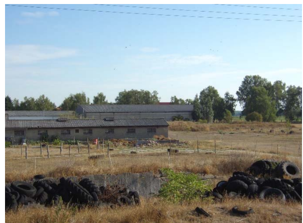
Mittlerer Bereich mit Fahrsiloanlage
